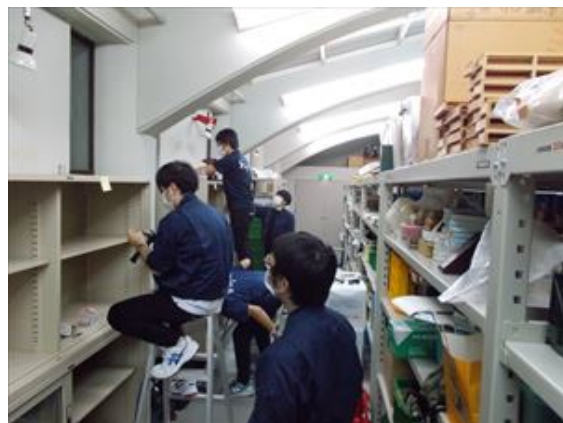
工学部外活動(風樹館転倒防止作業)
