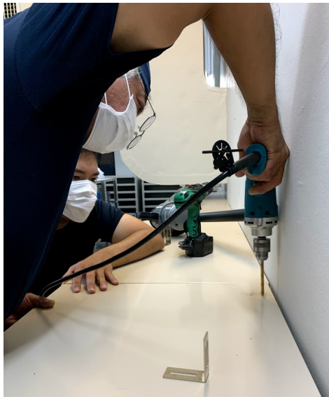
地震対策のための棚固定
