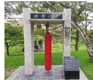
開学の鐘(レプリカ) の取付工事
