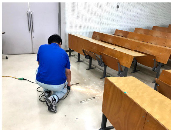
机入替作業の様子
