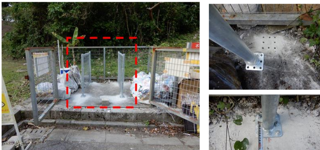
写真 ゴミ分別用の仕切りフェンスの設置
