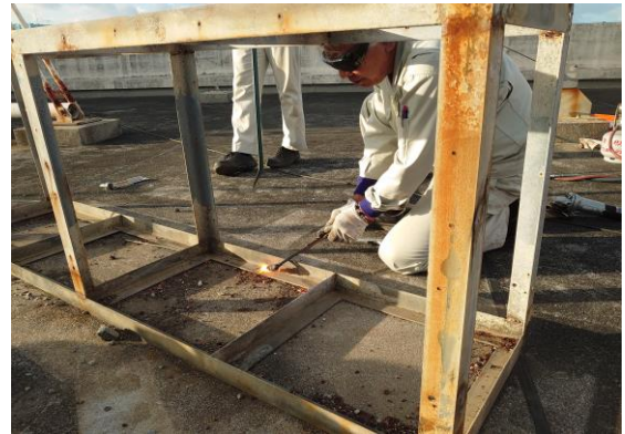
実験装置解体作業
