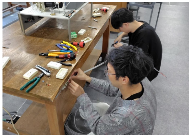
実験室コンセント交換作業
