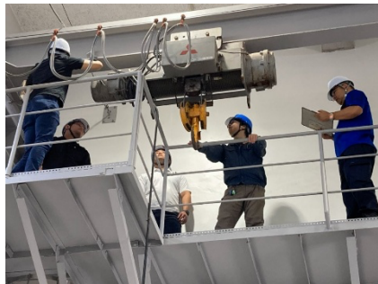
天井クレーン月次自主点検の様子
