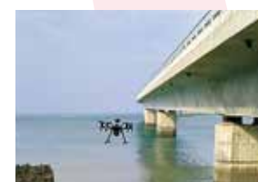
ドローンによる構造物調査
