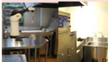
● 洗浄工程自動化ロボットライン
