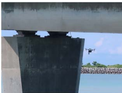
写真1 UAV 撮影状況
