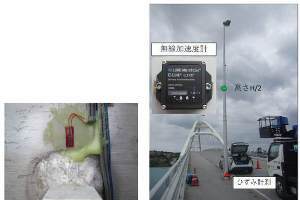
写真 2 ひずみゲージ 写真 3 無線加速度計の計測状況
