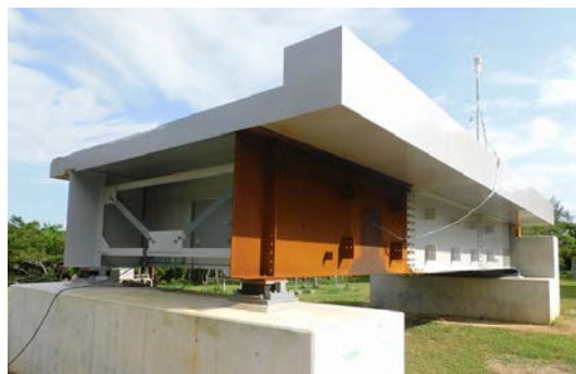
実物試験橋（工学部付属地域創生研究センター暴露場）
