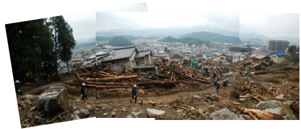
写真-1 2014年広島県土砂崩れの被災状況
