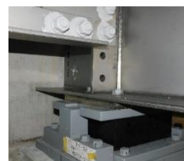
ステンレス鋼と炭素鋼のハイブリッド構造
