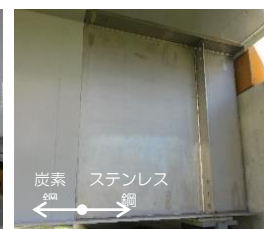
ステンレス鋼と炭素鋼のハイブリッド構造
