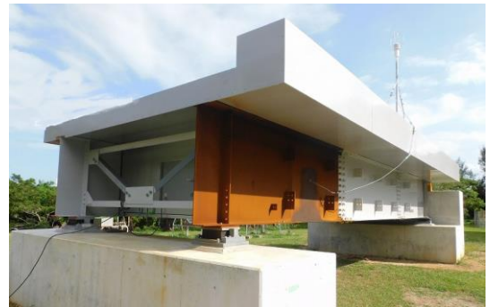
実物試験橋（工学部附属地域創生研究センター暴露場）
