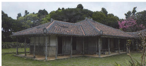
写真 1. 沖縄の伝統的な木造住宅（銘苅家住宅）
