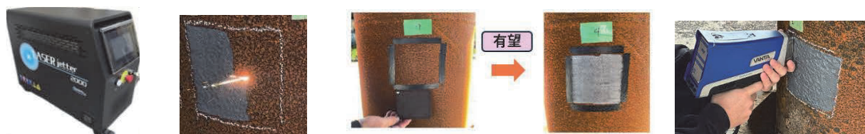
レーザージェッター（小型・軽量・高出力）を用いたサビと塩分除去体験
