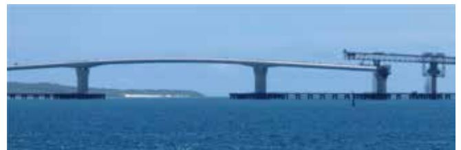
離島を結ぶ建設中の海上長大橋
