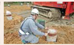
▲基礎杭の調査
