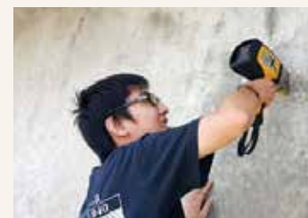
▲コンクリート構造物の調査
