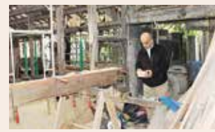
▲木造修復現場
