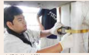
▲損傷柱の補強
