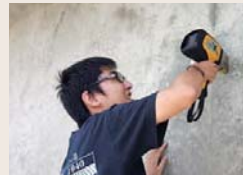
▲コンクリート構造物の調査
