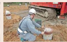
▲基礎杭の調査
