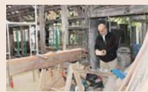
▲木造修復現場
