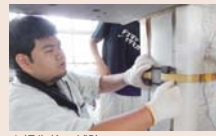
▲損傷柱の補強
